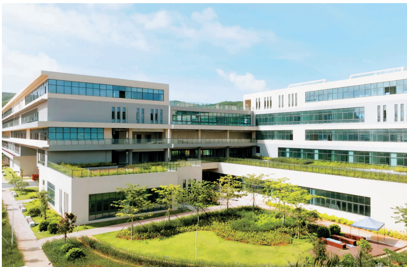
▲陵水黎安国际教育创新试验区的教学楼一隅。
